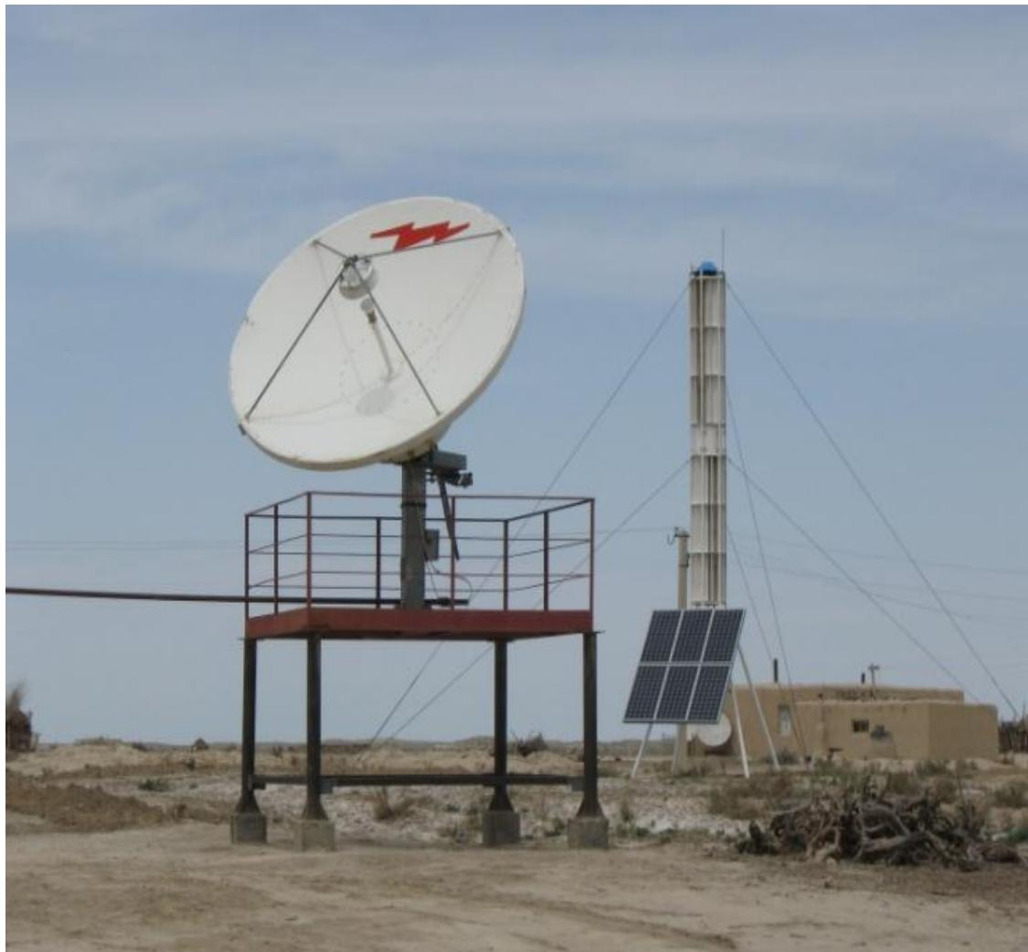
**Рис 15. КЭС ВРТБ -2,6 на объекте АО «Казахтелеком» Ажар одновременно обеспечивает питание электронного оборудования школы, интернет, интерактивную классную доску.**
