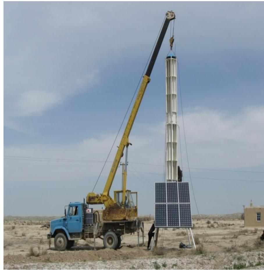
Рис 14. Строительство и монтаж комплексной энергетической системы ВРТБ в прикаспийской пустыне
